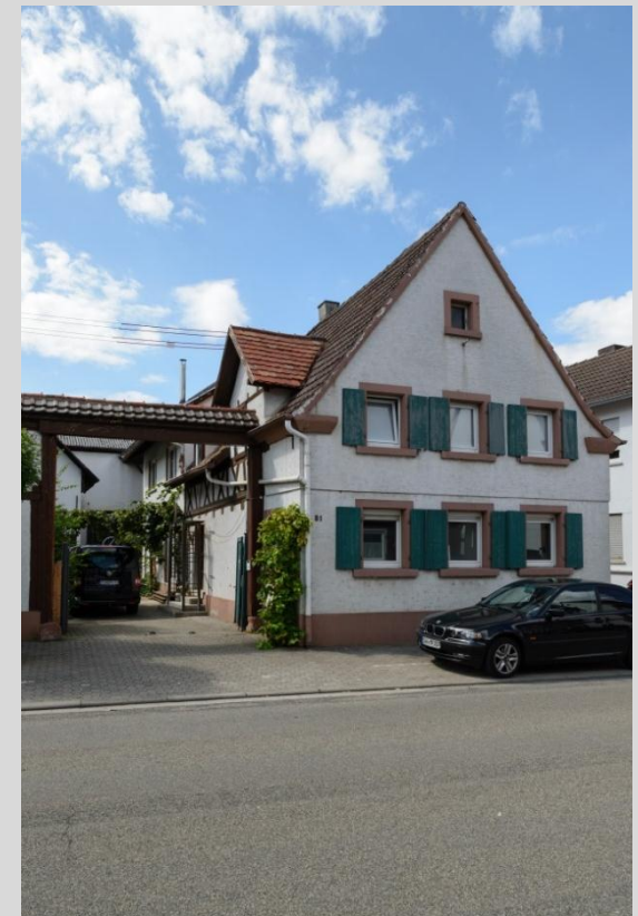
Wohnhaus, Ansicht von Osten.
