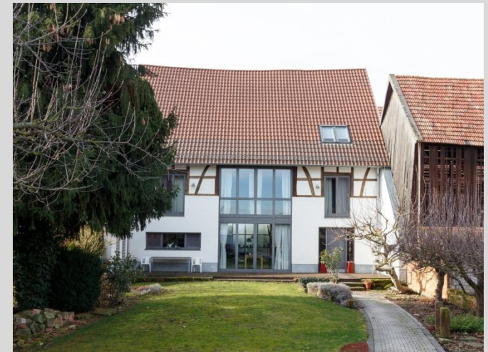
Ansicht von Osten.
