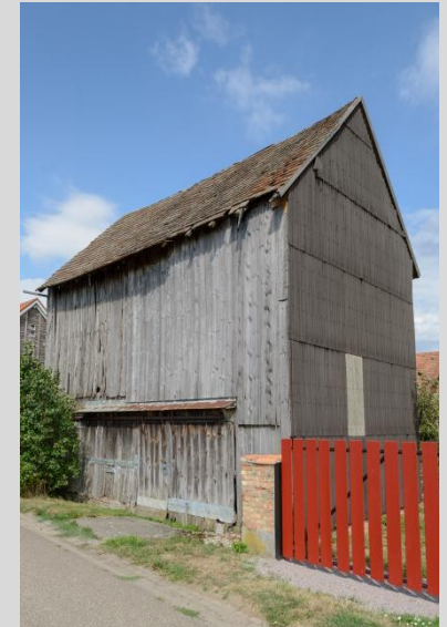
Tabakschuppen, Ansicht von der Friedhofstraße.
