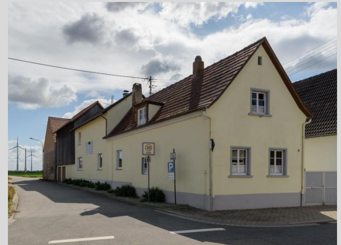
Wohnhaus mit Wirtschafts- u. Nebengebäuden, Ansicht von Nordwesten.
