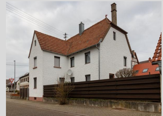
Haus Nr. 116, Ansicht von der Feldstraße.
