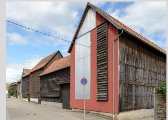
Tabakschuppen, Ansicht von der Friedhofstraße.
