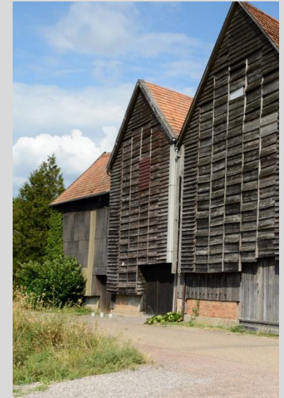
Mittlerer Tabakschuppen, Ansicht von der Friedhofstraße.
