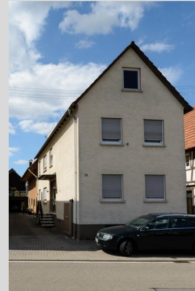
Wohnhaus, Ansicht von Osten.
