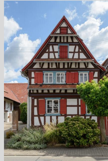
Wohnhaus, Ansicht von Osten.
