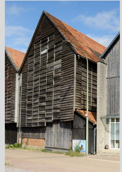
Tabakschuppen, Ansicht von der Friedhofstraße.
