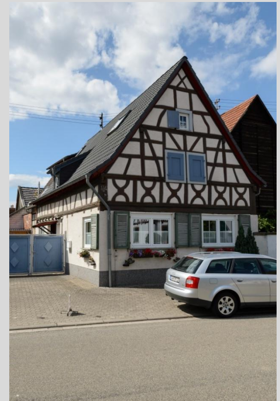
Ansicht von Osten.
