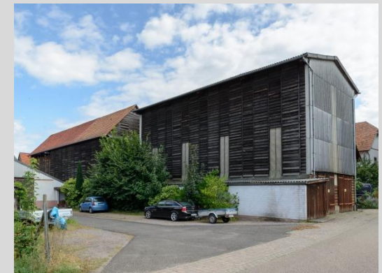
Tabakschuppen, Ansicht von der Friedhofstraße.
