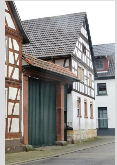
Toranlage, Ansicht von Nordosten.
