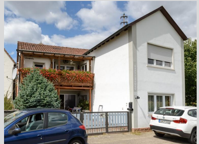
Ansicht von Osten.
