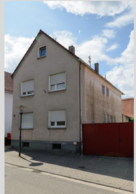
Wohnhaus, Ansicht von Osten.
