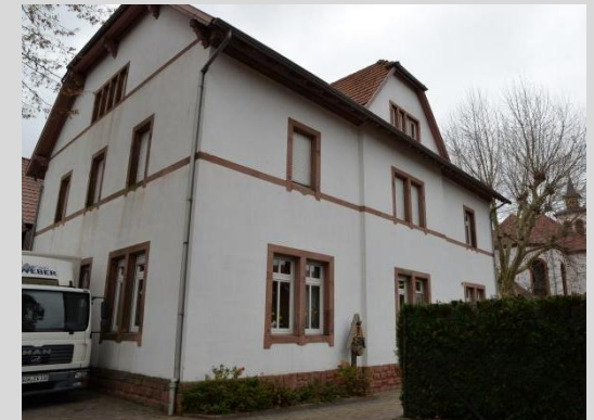
Ansicht von der Friedhofstraße.
