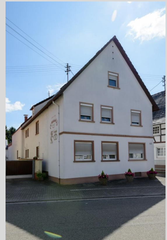
Wohnhaus, Ansicht von Osten.
