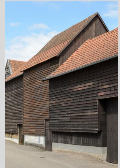
Tabakschuppen, Ansicht von der Friedhofstraße.
