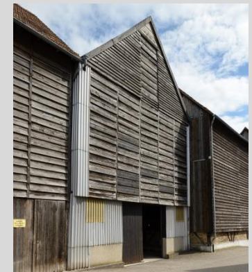
Tabakschuppen, Ansicht von der Friedhofstraße.
