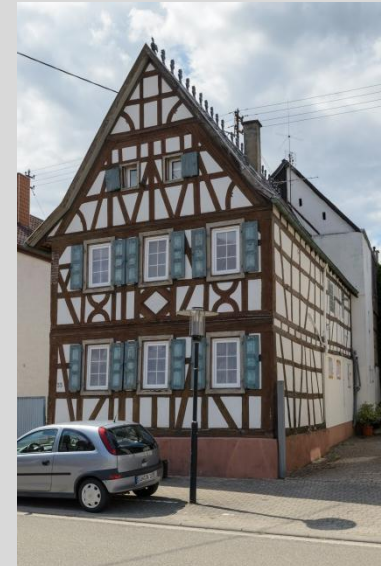
Wohnhaus, Ansicht von Osten.
