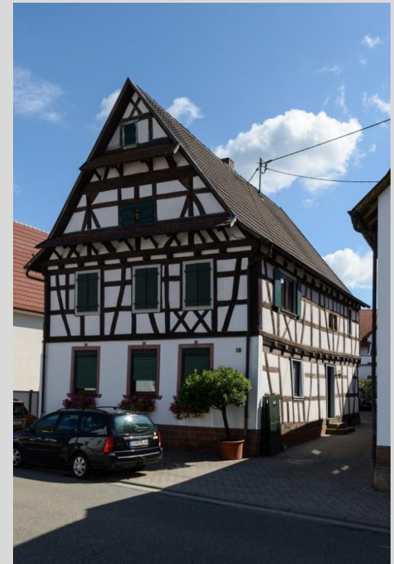
Wohnhaus, Ansicht von Südwesten.
