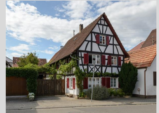
Wohnhaus, Ansicht von Osten.
