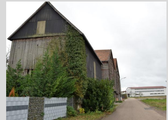
Tabakschuppen, Ansicht von der Friedhofstraße.
