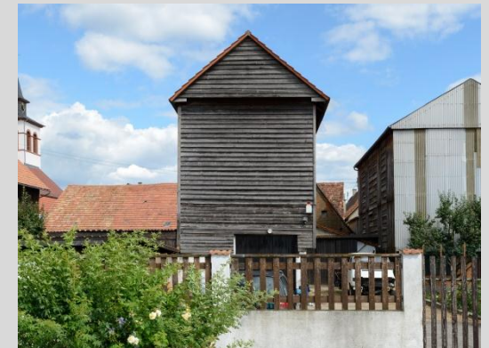
Tabakschuppen, Ansicht von der Friedhofstraße.
