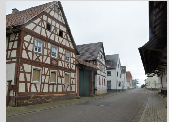
Straßenbild, Ansicht von Osten.
