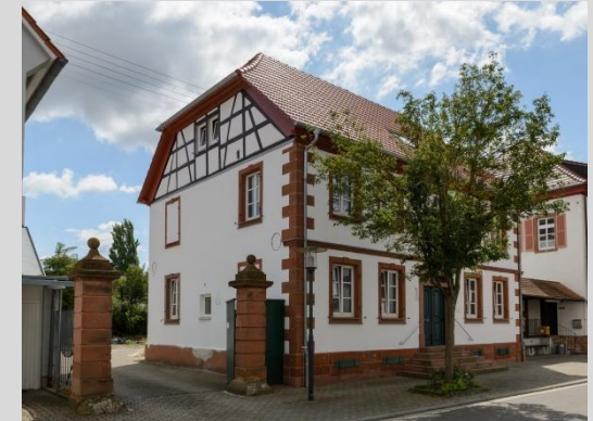
Ansicht von Nordwesten, mit Toreinfriedung.
