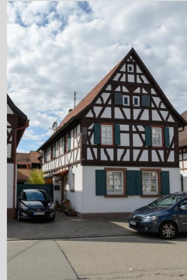
Wohnhaus, Ansicht von Osten.
