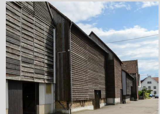
Tabakschuppen, Ansicht von der Friedhofstraße.
