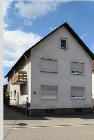
Wohnhaus, Ansicht von Osten.
