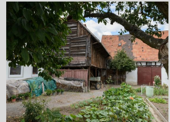
Hofgarten mit Wirtschaftsgebäuden, Ansicht vom Kapellenweg..
