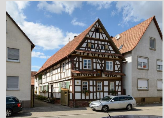
Wohnhaus, Ansicht von Osten.
