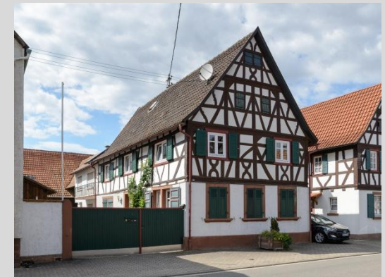
Wohnhaus, Ansicht von Osten.
