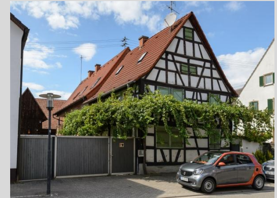
Wohnhaus, Ansicht von Osten.
