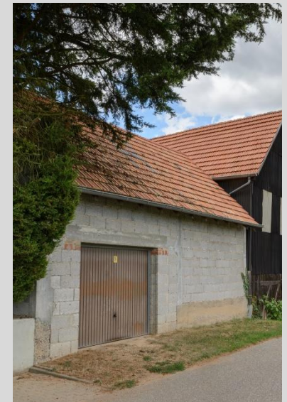
Nebengebäude (Garage), Ansicht vom Kapellenweg.
