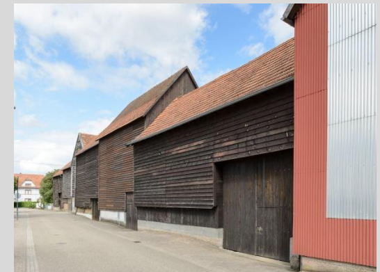
Tabakschuppen, Ansicht von der Friedhofstraße.
