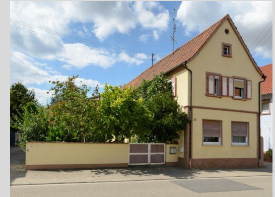
Wohnhaus, Ansicht von Osten.
