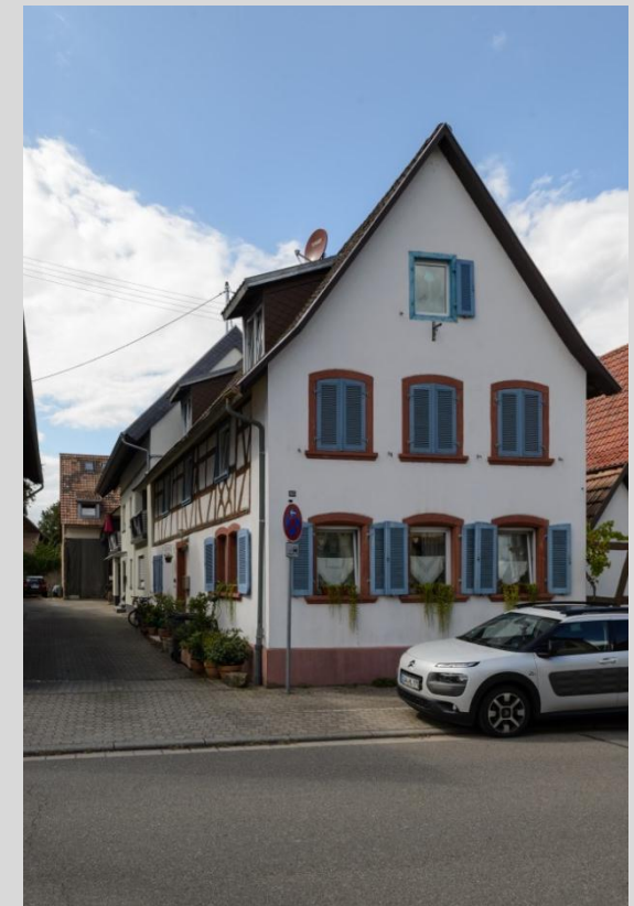
Ansicht von Osten.
