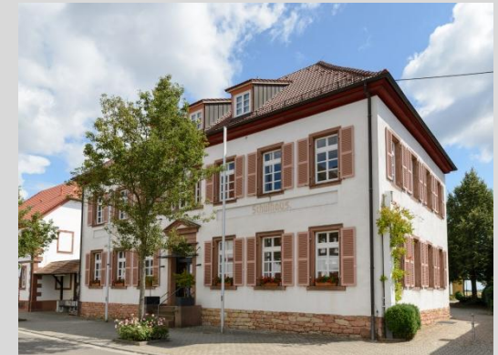
Ehem. Schule, Ansicht von Westen.
