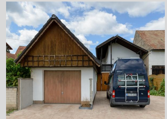
Garage, Ansicht von Osten.
