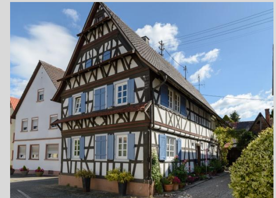
Wohnhaus, Ansicht von Südwesten.
