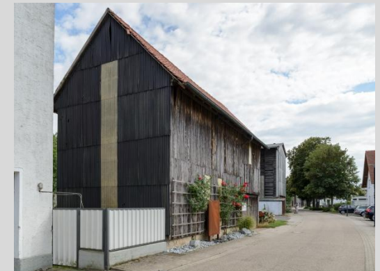
Tabakschuppen, Ansicht von der Friedhofstraße.
